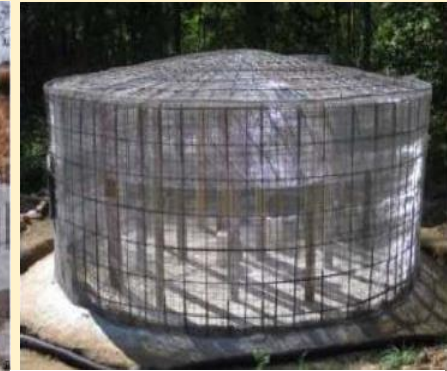
2. Construir el marco a partir de barras de refuerzo cubiertos con varias capas de malla de alambre.
