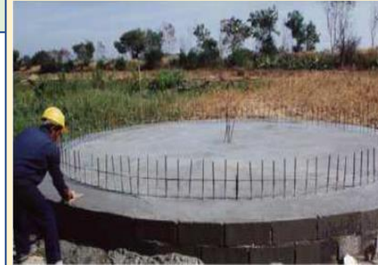
1. Construir la base de hormigón reforzado con hierro.
