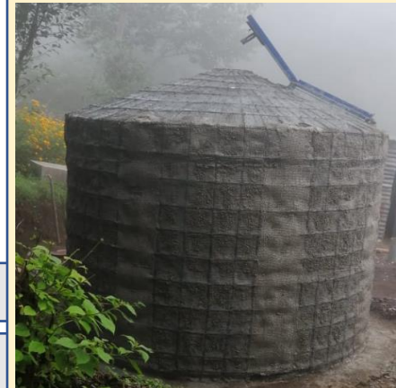
Aplicar yeso de cemento al marco para proporcionar la estructura estanca
